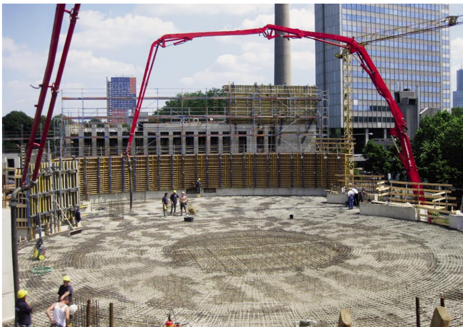
Betonage der Decke über dem Konferenzsaal und Schraubanschlüsse
