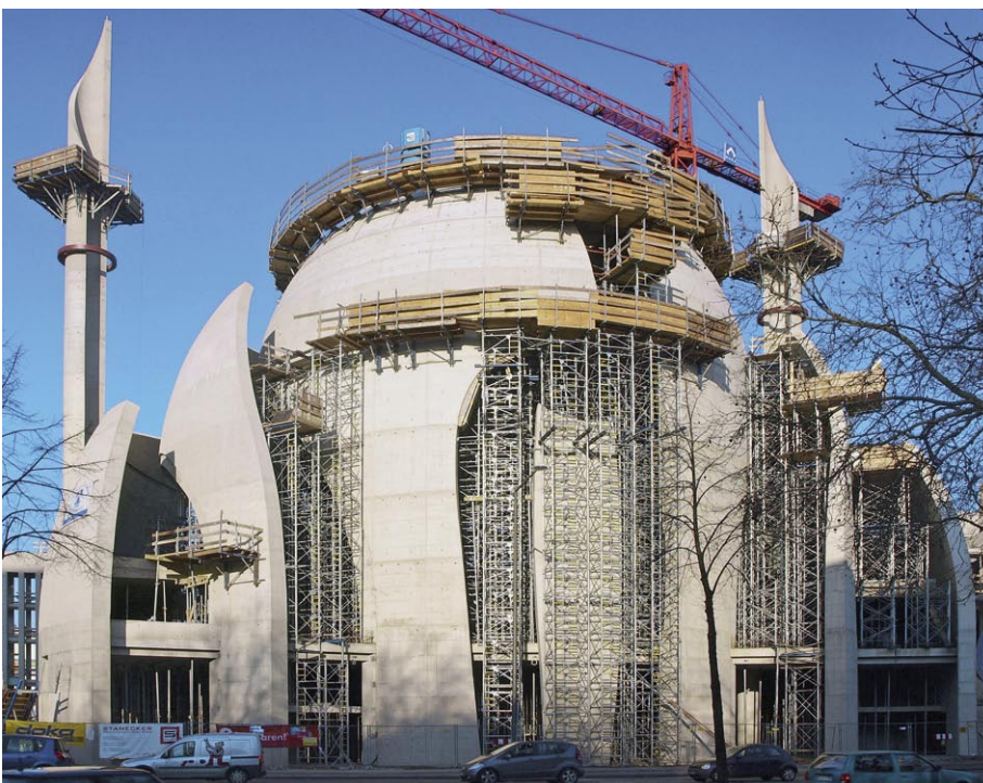
Mehr als 2000 m 2 runde und dreidimensional gewölbte Sonderschalungen für die komplexe Geometrie der Kuppel hat der Doka-Fertigservice maßgenau vormontiert.
