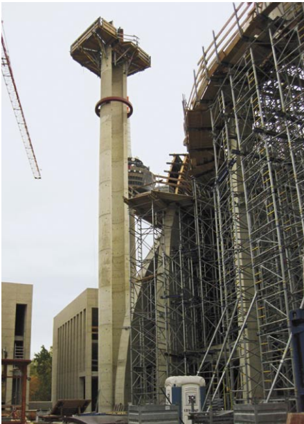
Minarett mit Blick in den offenen Querschnitt während der Bauphase
