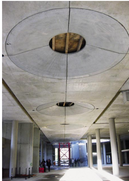
Sichtbetonabhangdecke mit Lichtaue in der Einkaufspassage
